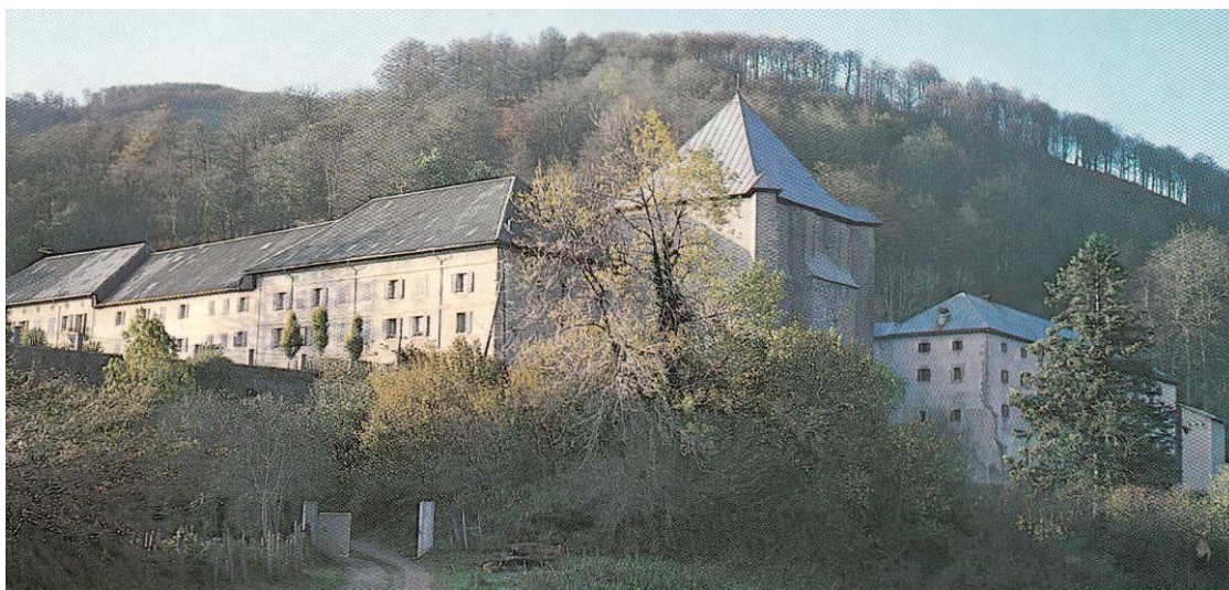
Die grosse Pilgerherberge mit Spital und Kirche in Roncesvalles
